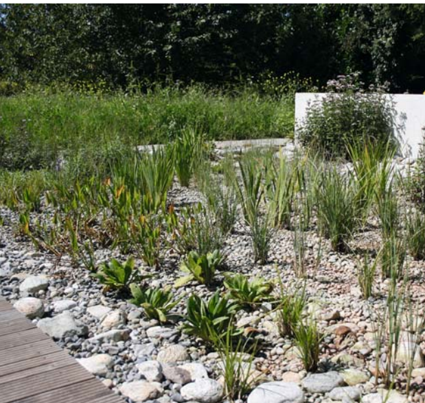
Die Klärzone wird zu 100 Prozent mit Wasser reinigenden Pflanzen bestückt.
